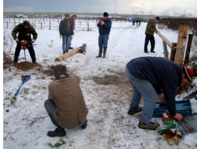
De Vrienden plaatsen een afsluitbaar toegangshek
